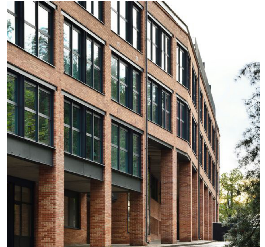
Aan de kant van de Wagenwerkplaats een industriële "wand" van baksteen en staal.
