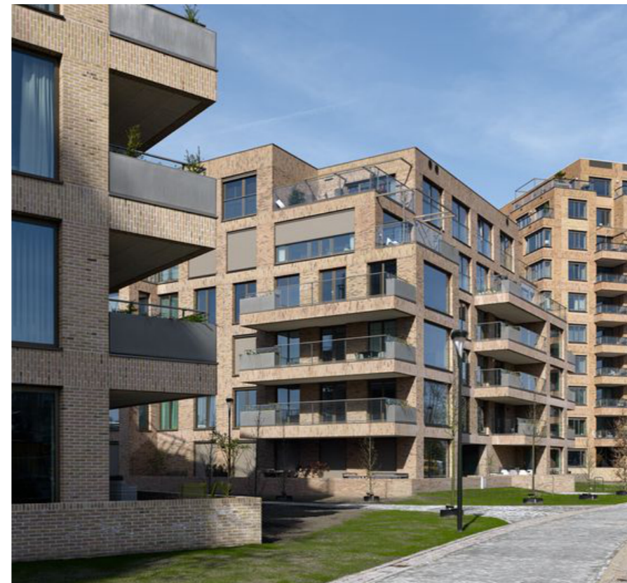
Buitenruimte in de vorm van loggia's/ terrassen.
